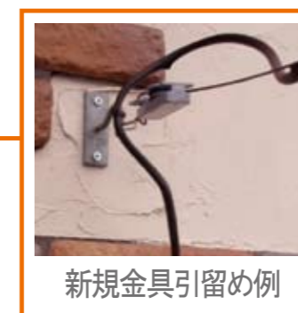
外壁への配線
